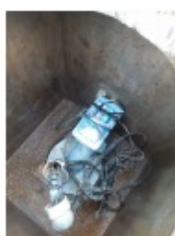
マンホール内水位計、流量計と LoRa送信器
