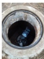
マンホール内水位計、流量計と LoRa送信器
